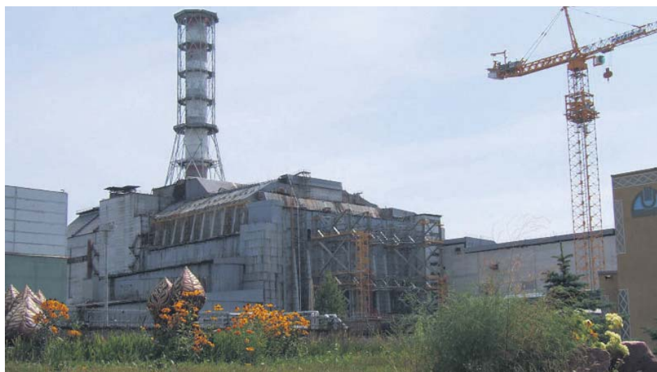
4-й энергоблок ЧАЭС
